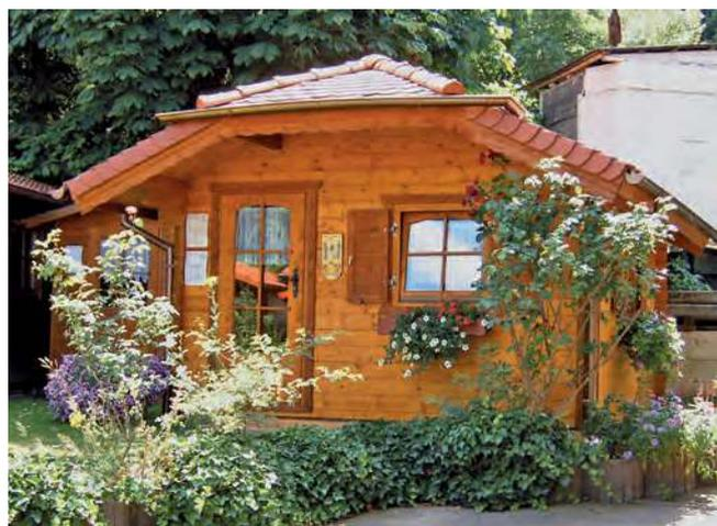
Das Saarlandhaus in der Variation mit **Krüppelwalmdach** statt Satteldach überschreitet die 30 cbm umbauter Raum geringfügig, da die Dachneigung von 15° auf 25° erhöht ist.
